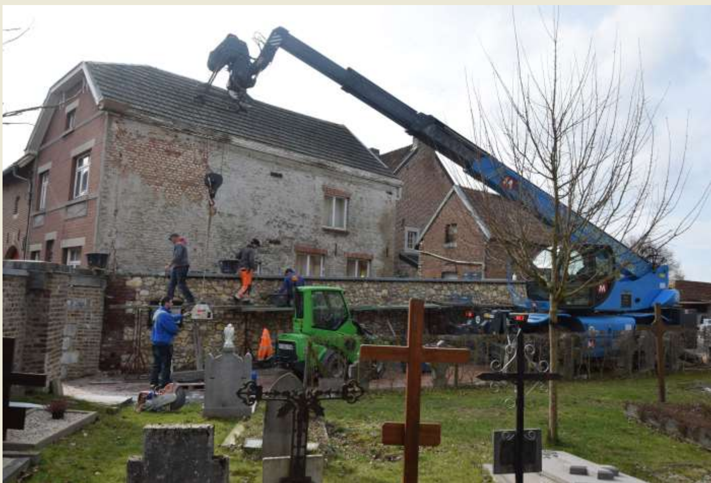
Renovatie kerkhofmuur Sint-Martens-Voeren
