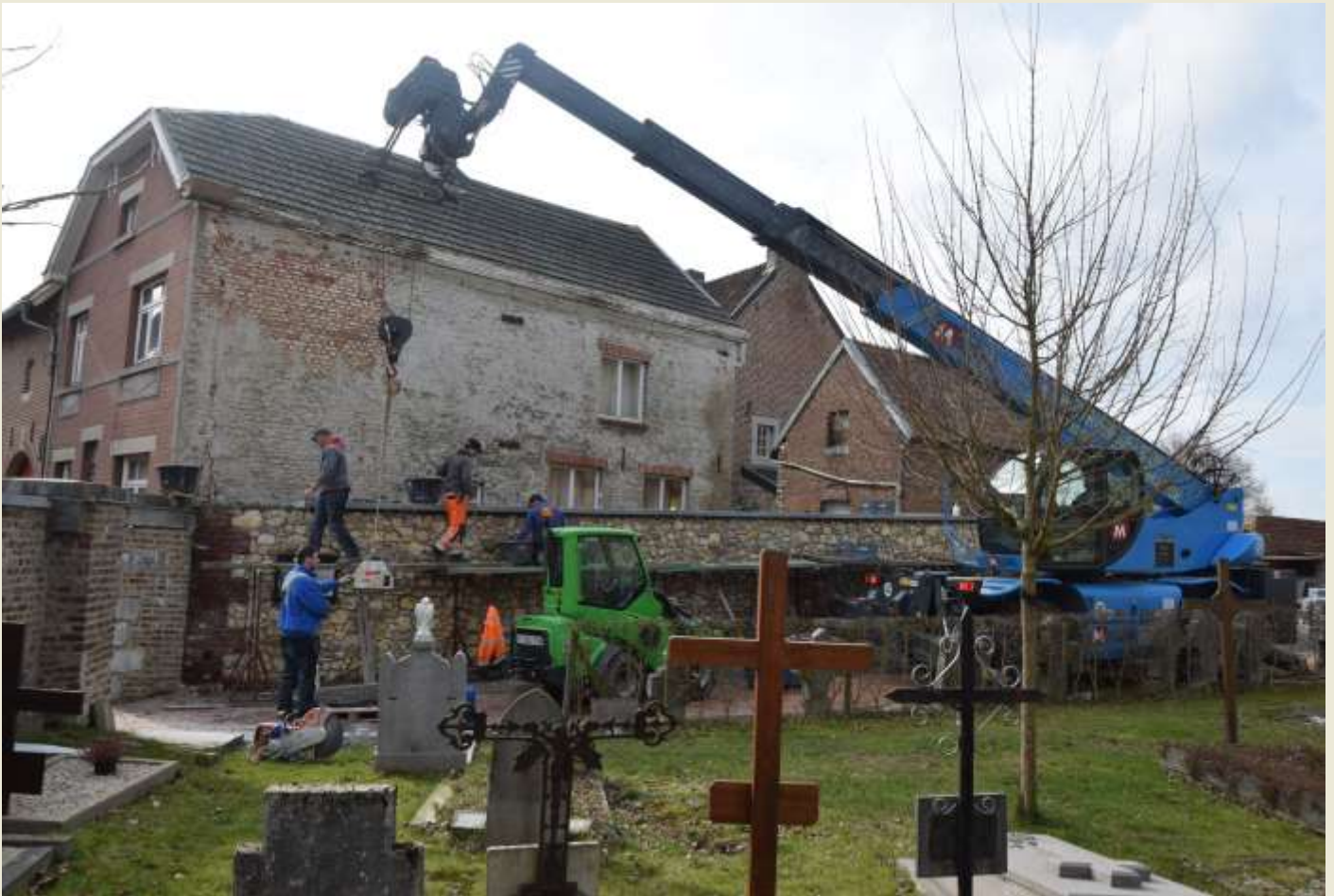
Rénovation du mur du cimetière Fouron-Saint-Martin
